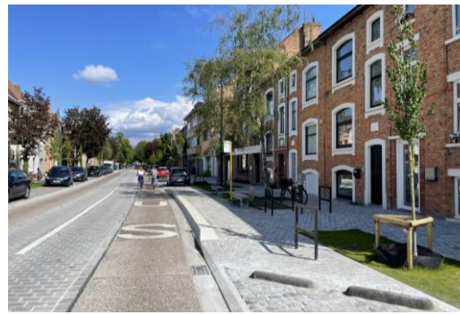
Referentie Karel De Stoutelaan, Brugge: fietsstroken in comfortabele verharding, resterende middenstrook in kasseien om het verkeer te vertragen en fietsers visueel voorrang te geven.
